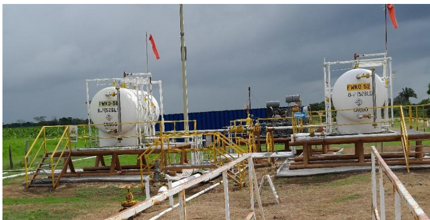
Figura 1. Separadores horizontales in situ en campo de producción Ogarrio.
