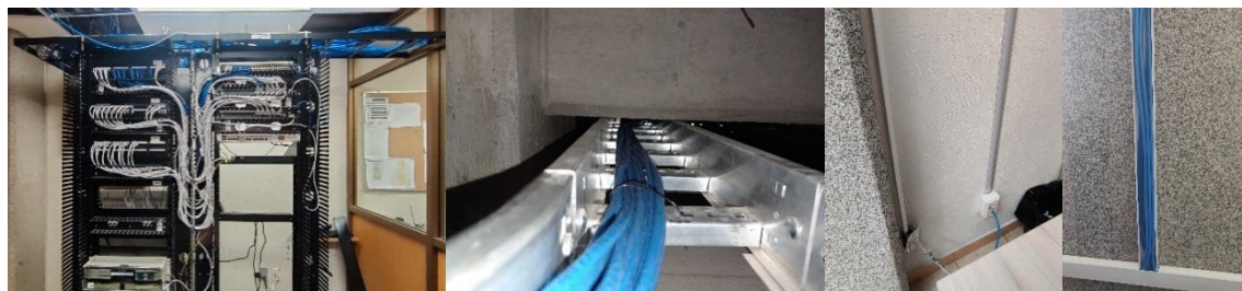
(Figura 5. Cable de red actual observando las normas ANSI-EIA-TIA 568b y 606– Autoría propia.)
