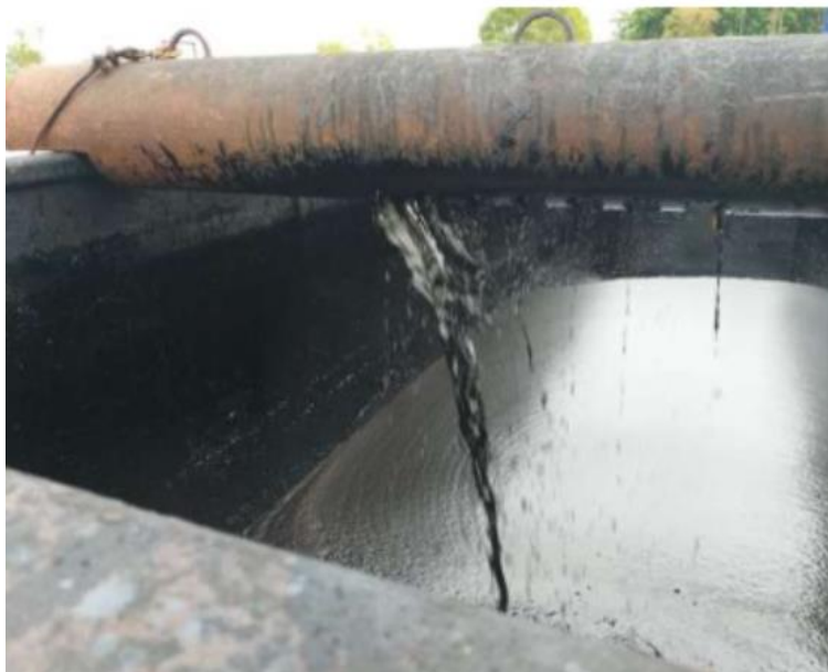
Figura 9 Descarga de hidrocarburo en la presa de medición 30 m 3 (Fuente propia).
